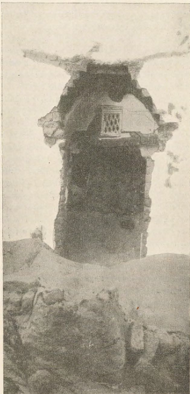
Fig. 4. — Fenêtre de la maison marquée A sur le Plan.
